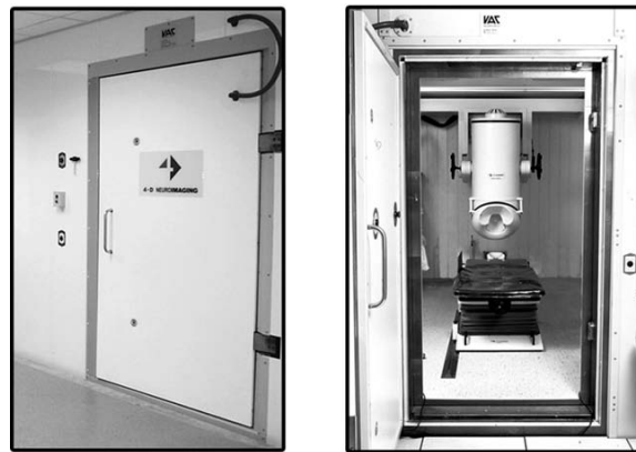
Figure 4.12 – Chambre blindée d'un système MEG, extrait de [28].
